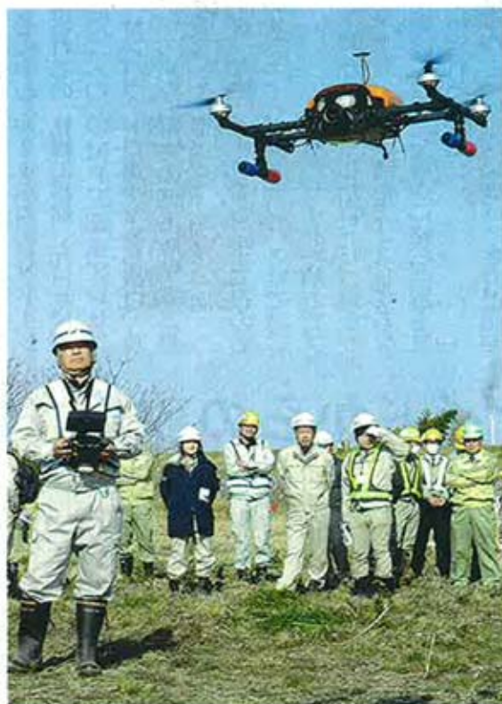
ドローンを使った測量実験をする建設業者ら。岐阜市今嶺の長良川河川敷で
