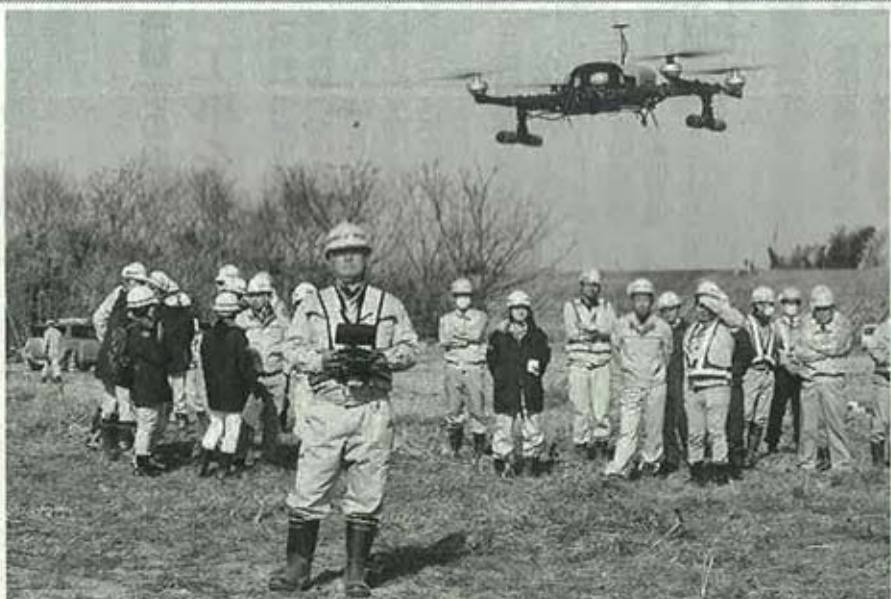
長良川左岸の工事現場で 無人航空機試験測量飛行
